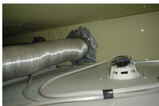
写真 3-3-2 ダクト貫通部の気密処理の例
